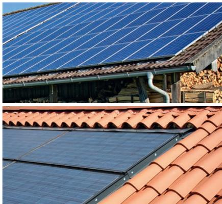
**Aufdach-PV-Anlage (oben) und Indach-PV-Anlage**
